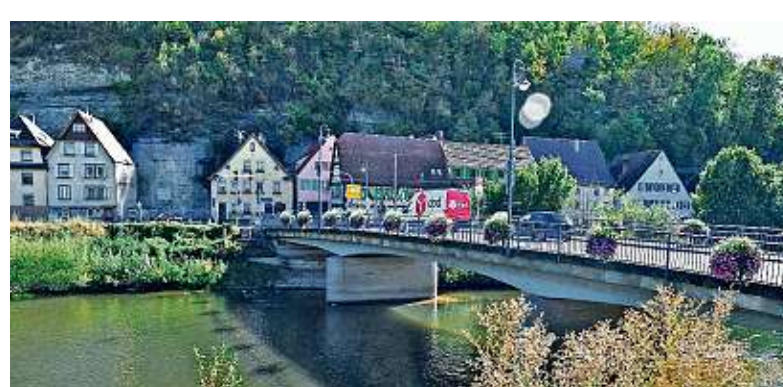
Der Neubau der Herrenwaagbrücke soll baldmöglichst erfolgen. FOTO: LUTZ/PZ-ARCHIV
